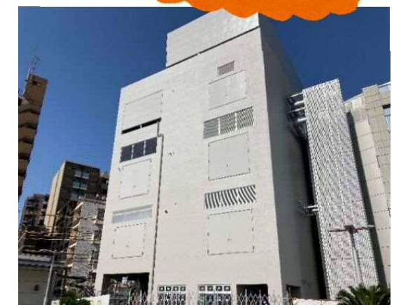
新しい移転先であるエネルギー棟
